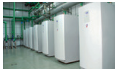
Sedm vzájemně propojených Thermia Robust Eco jednotek.
